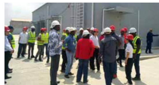
施工现场 Local de construção
