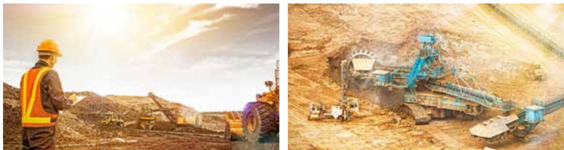
施工现场 Local de construção
